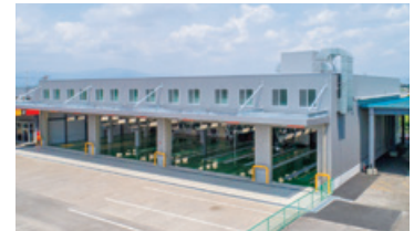
岐阜日野自動車 安八営業所整備工場
