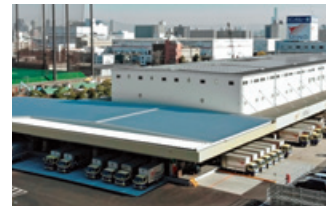
西濃運輸 大阪西支店の増築
